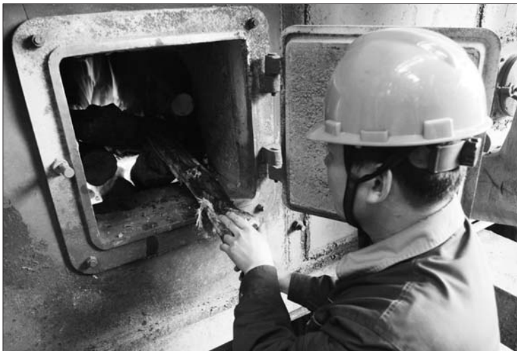
2012年11月14日,热力公司点燃了锅炉,准备开始一年的供暖。
