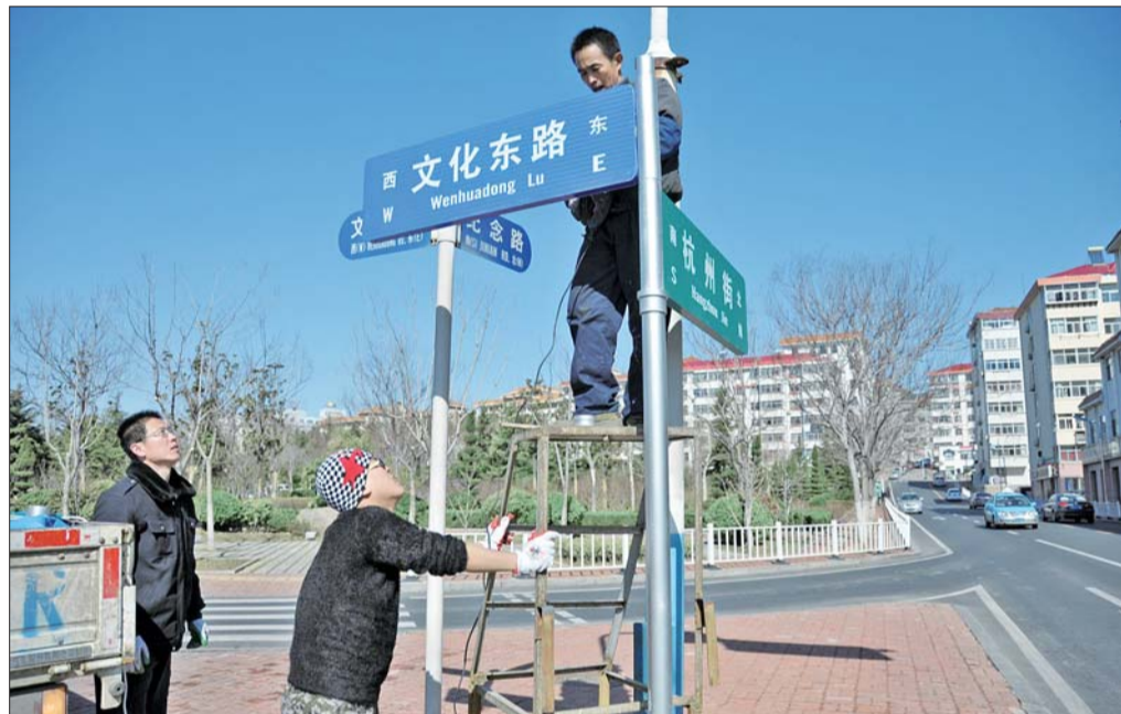
▲工作人员正在安装道路指示牌。见习记者 赵辉 摄
