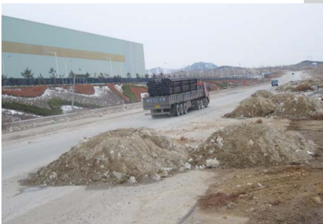
建筑垃圾堆在马路中央,车辆只能在路南侧行驶。记者 侯艳艳 摄
