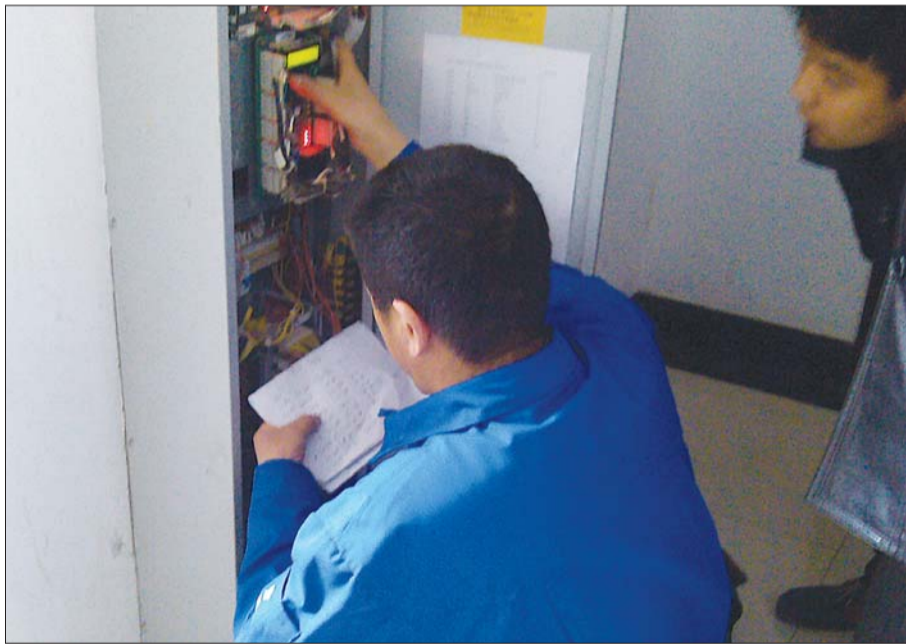
维修人员正在检测电梯。
