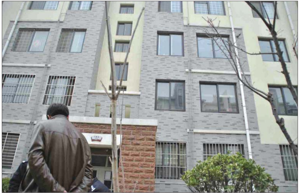
楼外的燃气和排水管道,成了小偷翻窗入室的“梯子”。
