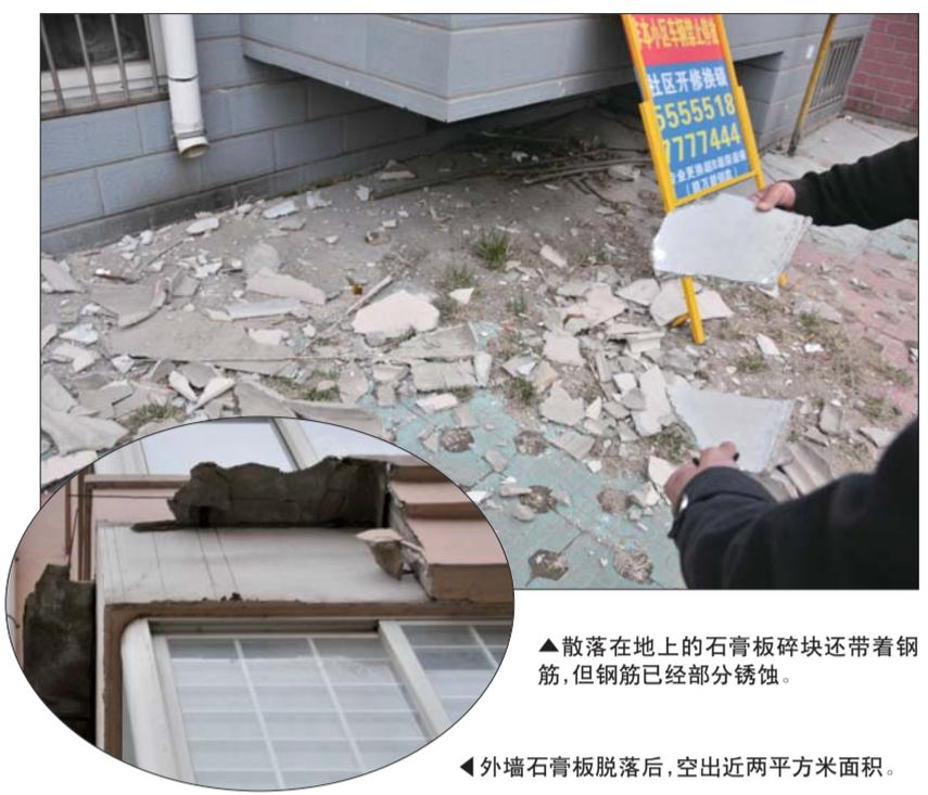
▲散落在地上的石膏板碎块还带着钢筋,但钢筋已经部分锈蚀。
