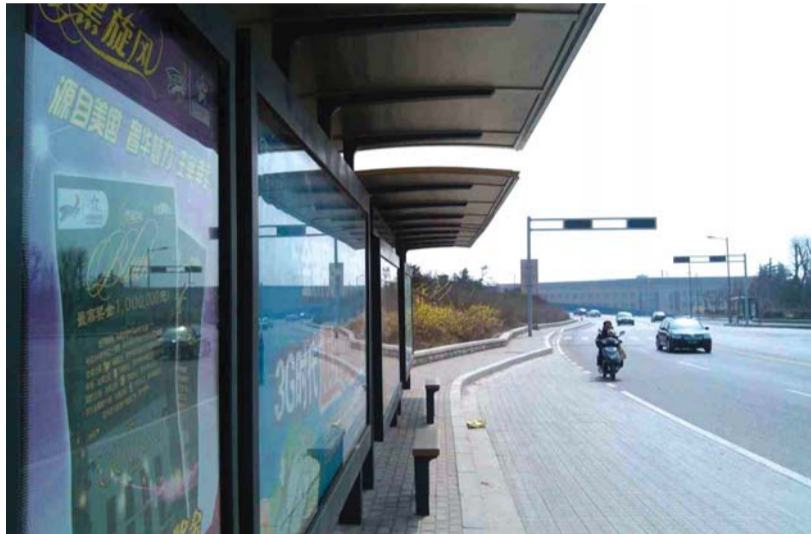
环山路市政府以西已经建好公交停车港湾,但没通公交车。
