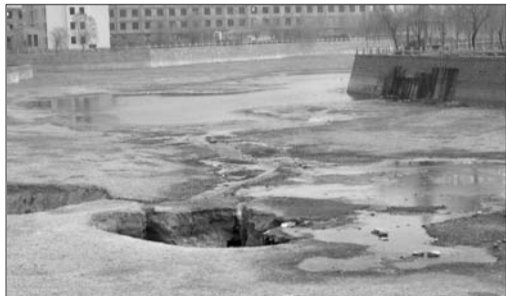
污水倒灌进水源地。 本报记者 白雪岩 摄
