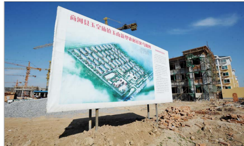
▲建设中的玉皇庙镇玉路新型农村社区可容纳7个村的居民居住。本报记者 张中 摄
