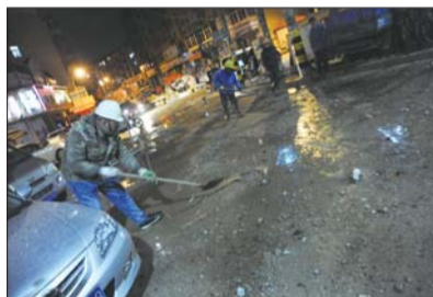
施工人员正在清扫路面上的石子和泥。
