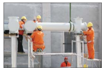
工作人员正在对220千伏临邑变电站进行智能化改造。 本报通讯员 李玉刚 王衍 摄
