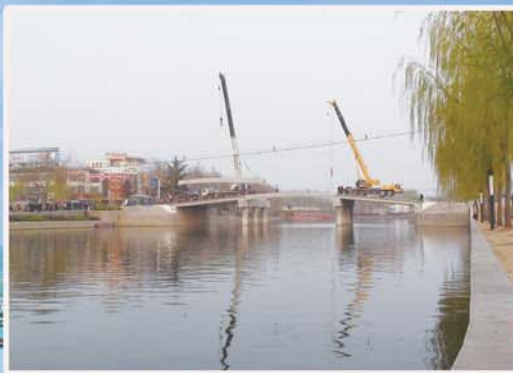
兴中桥桥板吊装
