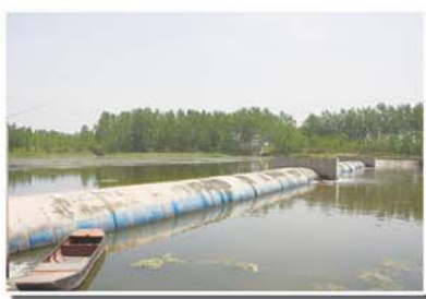
前石佛寺橡胶坝
