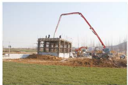
建设中的提水泵站
