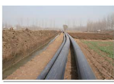
输水管道的铺设
