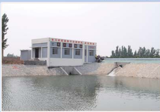
高效节水工程二级站
