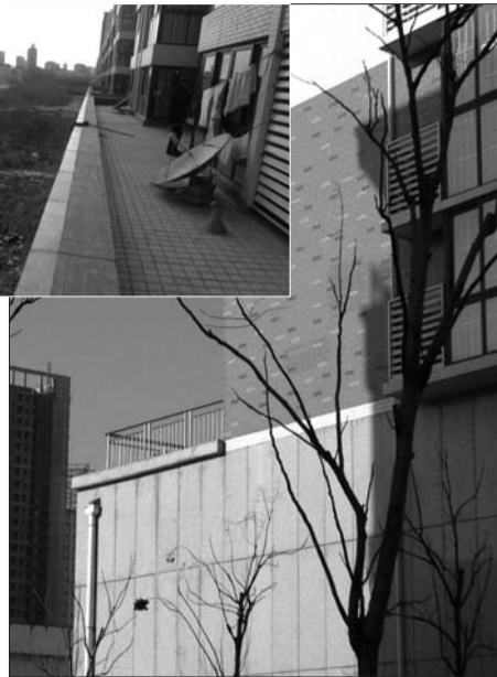
▲安置房的露台上没有安装护栏。
