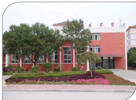
即将拆迁的美术楼。
