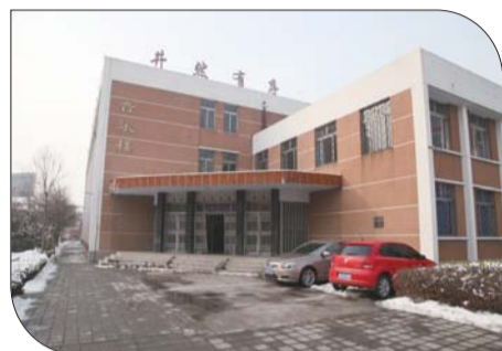
拆迁前的音乐楼。
