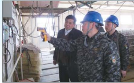
3月25日,工作人员对一养鸡厂用电设备的接点进行测温。
