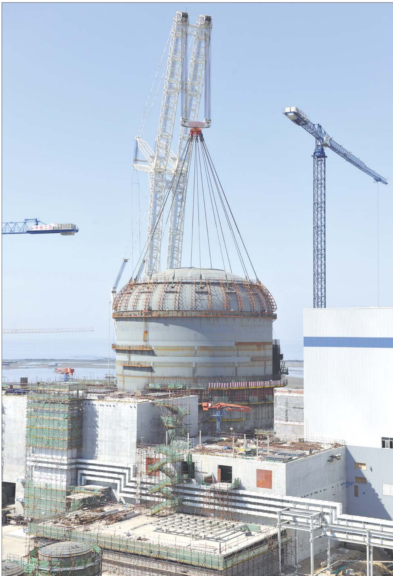
3月29日,海阳核电1号机组钢制安全壳顶封头顺利吊装就位,为1号机组顺利发电奠定了基础。
