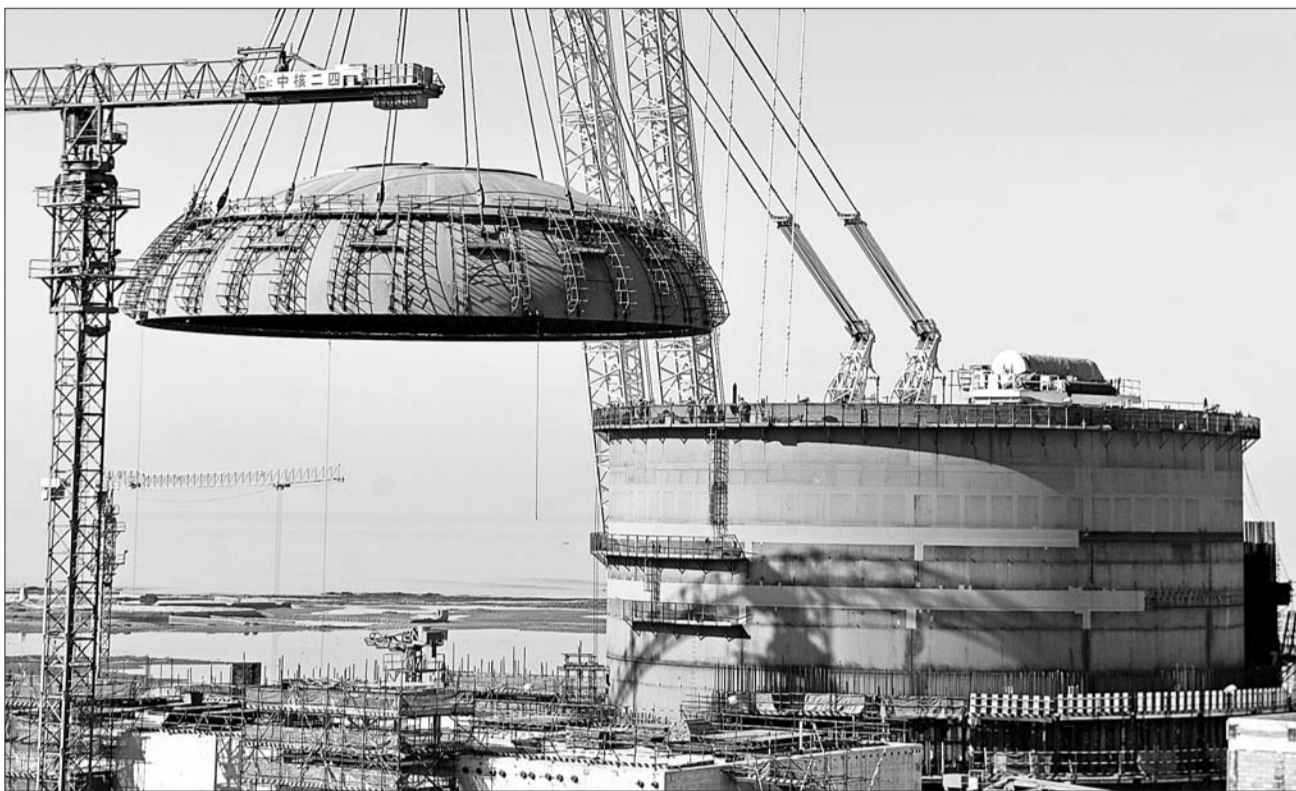
3月29日,山东海阳核电1号核岛安全壳成功封顶。图为吊装中的海阳核电1号机组钢制安全壳顶封头。 新华社发
