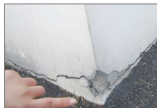
尽管铺上了沥青,环翠里26号楼墙体上的裂缝能插进手指。记者 侯艳艳 摄
