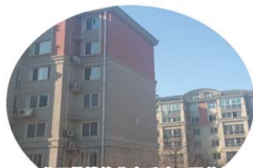
家住57号楼的业主反映,双羊新城小区的太阳能供水系统经常出问题。
