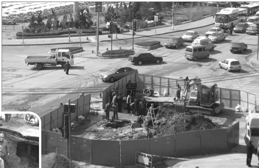
▲长沙路与周口路路口附近一自来水管破裂,路口立起围挡。程凌润 摄 ▲工作人员正在抢修。程凌润 摄
