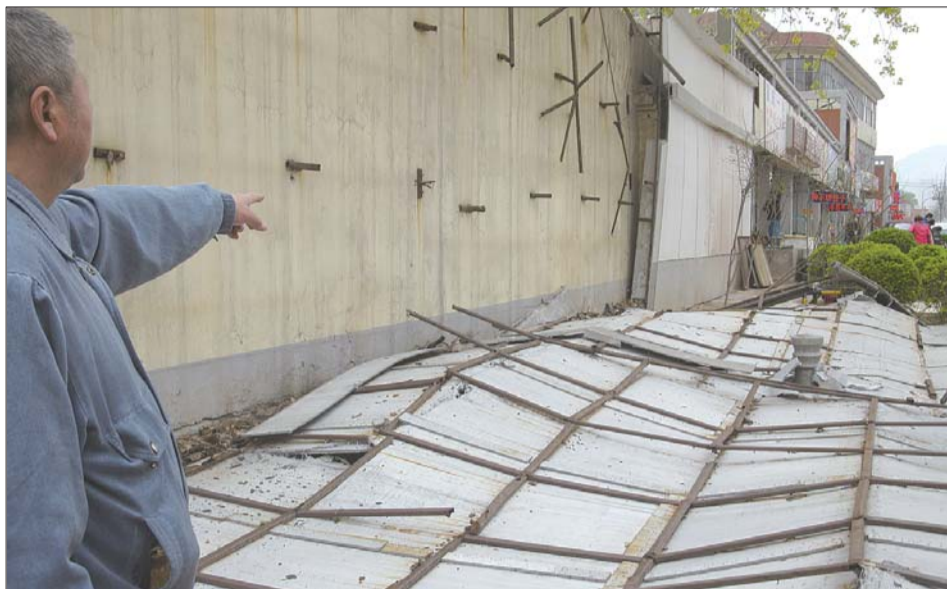
装饰墙被大风吹倒后,露出里面破旧的墙体。本报记者 王倩 摄
