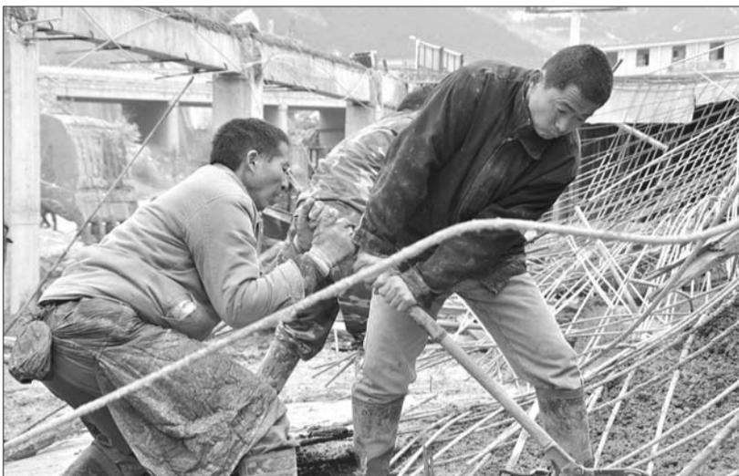
工人用钳子剪断塌方混凝土中的钢筋实施救援。
