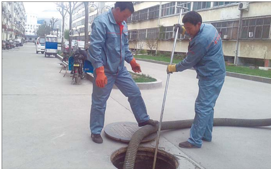
▲两名工作人员在清理化粪池。
