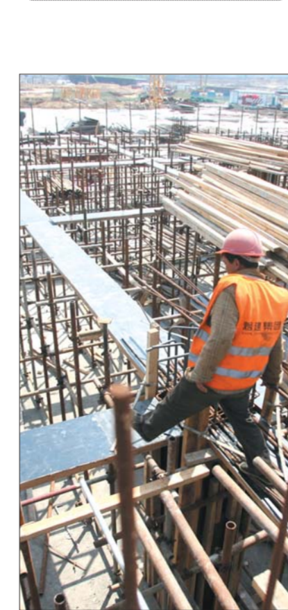
机场旁边在建的大型地下停车场,工人正在施工。记者 赵金阳 摄
