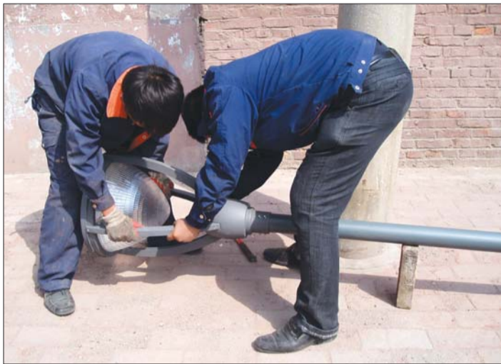
工作人员正在幸福街社区安装路灯。 本报记者 秦昕 摄
