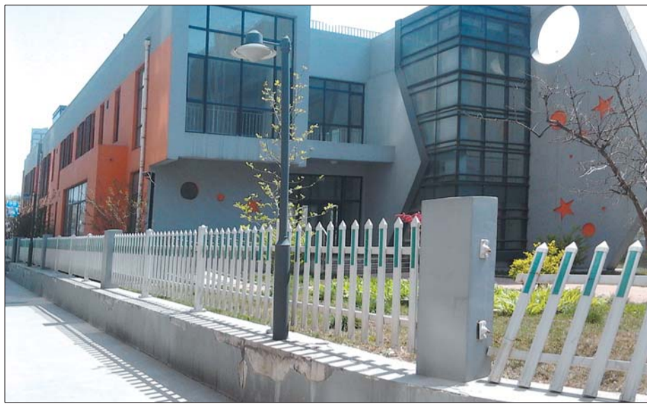
幼儿园建成两年了,但是迟迟没有招生,图为高新区康桥颐东小区幼儿园。 本报记者 陈伟 摄
