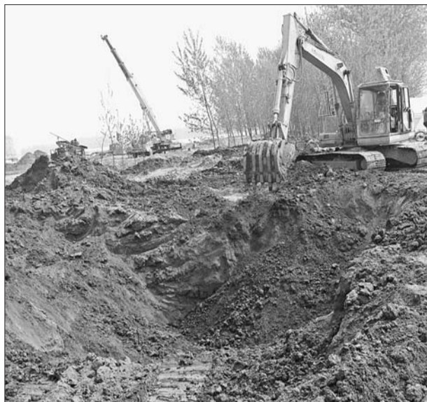
挖掘机正在回填救人时挖出的土。 本报记者 王尚磊 摄
