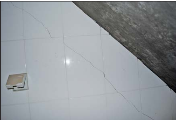
▲阁楼洗手间墙壁裂缝仍未处理。
