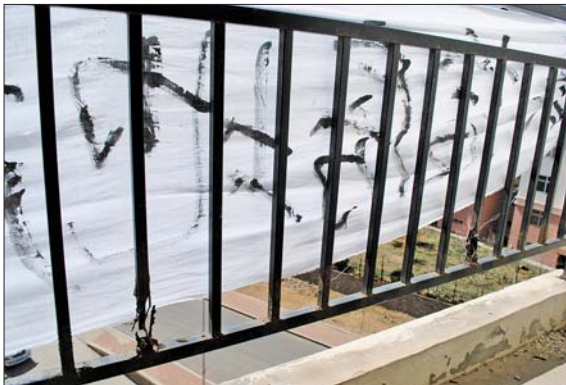
▲阳台护栏已有两段锈蚀。
