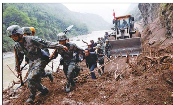
21日,救援人员在武警水电部队临时开辟的道路上通行。新华社发
