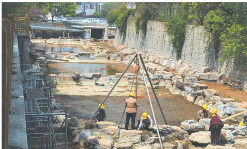
施工人员正在铺设拦水坝。
