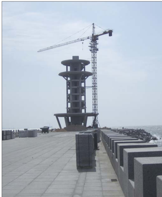
码头上的灯塔正在进行最后的建设。记者 孙芳芳 摄
