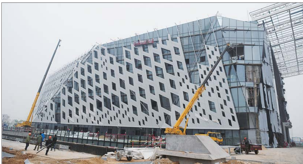
十艺节三馆正在安装玻璃幕墙。 本报记者 周青先 摄
