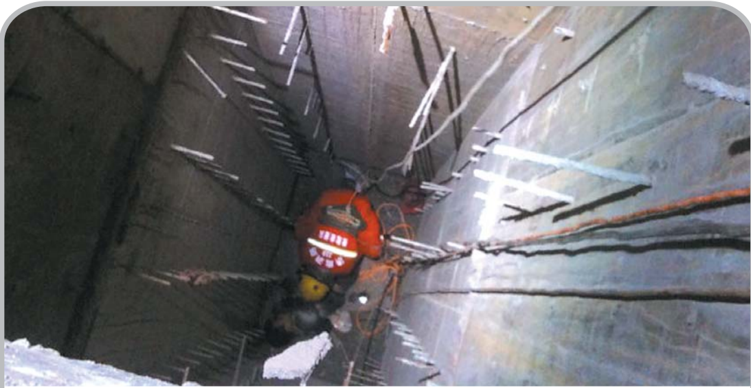
消防人员下井救援。 通讯员 姜志 摄
