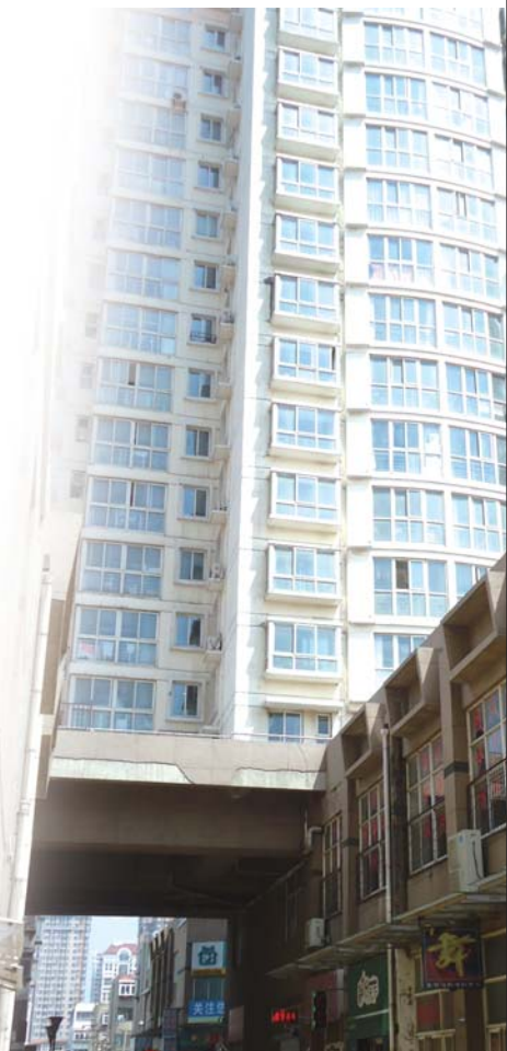
电梯“停摆”，楼上的居民只好每天爬上爬下，直呼受不了。记者 于飞 摄
