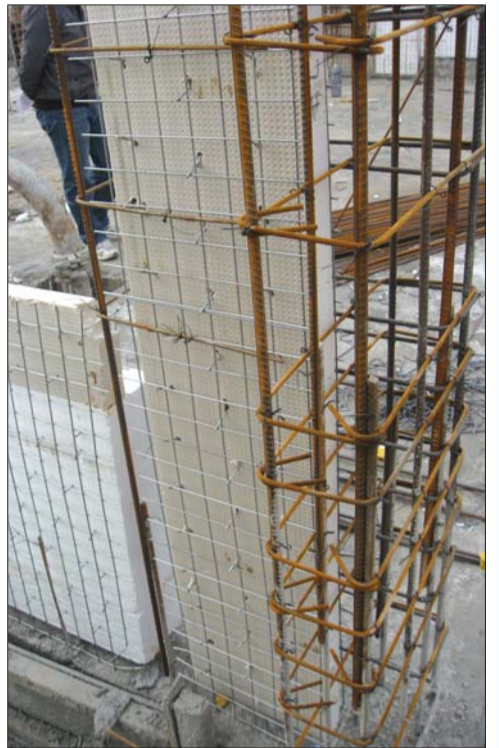
CL复合剪力墙施工现场。(资料片)
