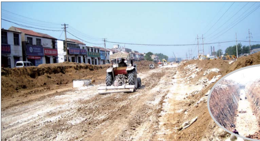
◀金宇路西段开始平整道路。本报记者 王洪磊 摄
