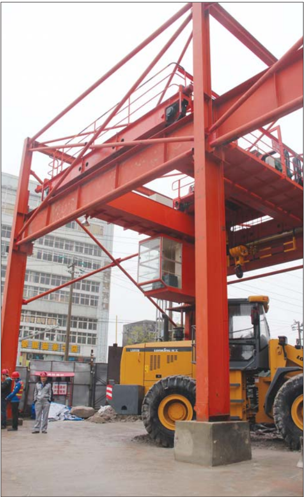
钢筋防护棚将搭建在该支架外侧,降低噪音减少扬尘。(图片由地铁指挥部提供)
