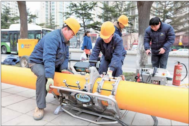
▲青岛路附近,威海港华燃气有限公司工作人员正在进行铸铁管改造。(图片由威海港华燃气有限公司提供)
