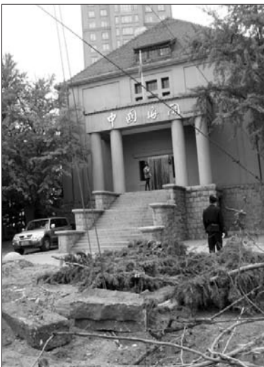
被拆除的大港海关楼前花园。 陈之焕 摄
