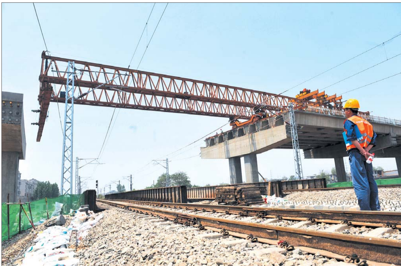
15日11时40分,二环西路高架桥缓缓跨过京沪铁路。 本报记者 张中 摄
