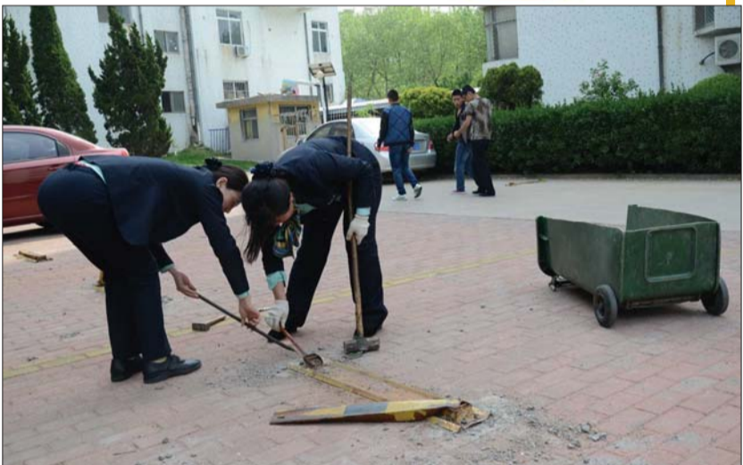
新时代物业公司工作人员正在拆除车位锁。
