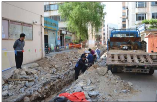
工人正在施工。本报记者 陈新 摄
