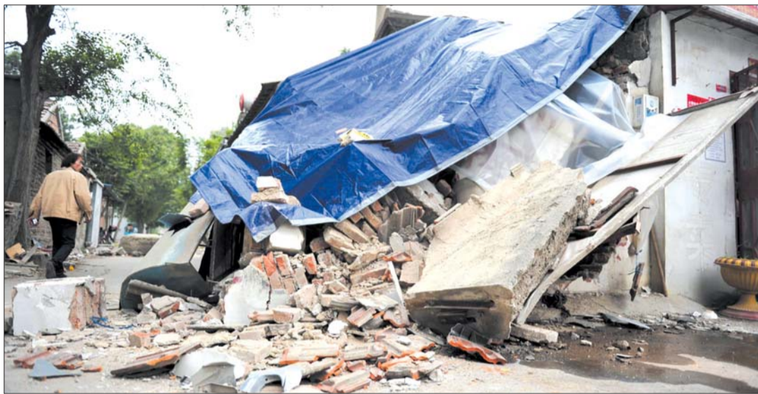
17日,在白马山西路上,由于怕下雨,被越野车撞塌的超市被塑料布盖上。 本报记者 王媛 摄
