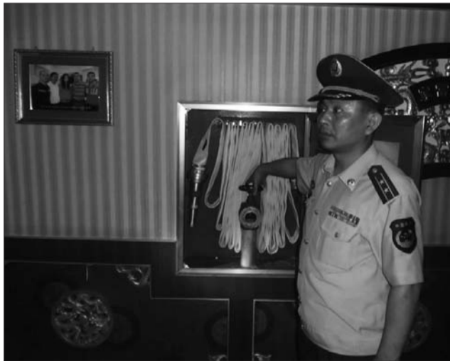
君临盛世室内消防栓有气无水。本报记者 刘涛 摄
