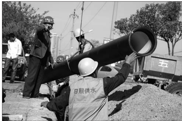
20日下午,施工人员敷设新的供水管道。 本报记者 李玉涛 摄
