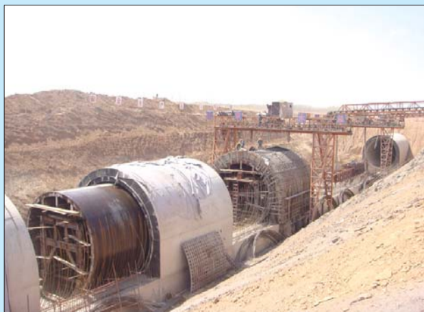
2010年4月13日滩地埋管外部浇筑施工。
