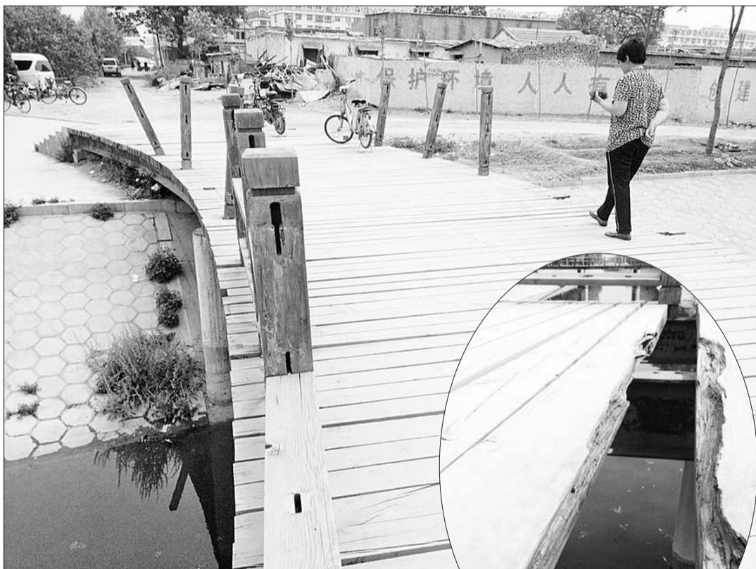
▲一座木桥上,护栏成片的缺损,只剩几根桥柱。
