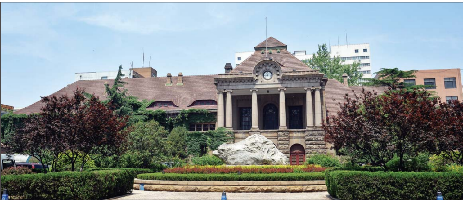
原胶济铁路济南站作为其它用途,仍在使用中。
