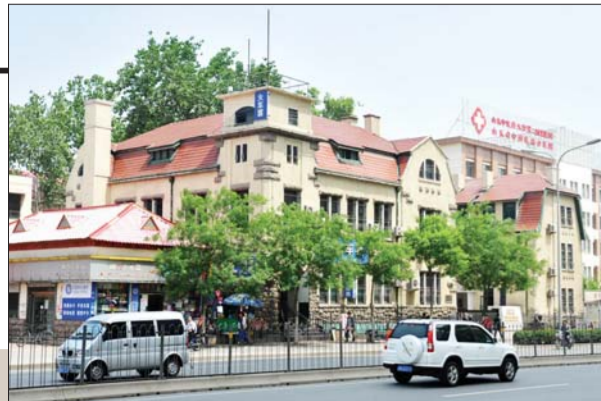
原胶济铁路济南站东侧办公用房。
