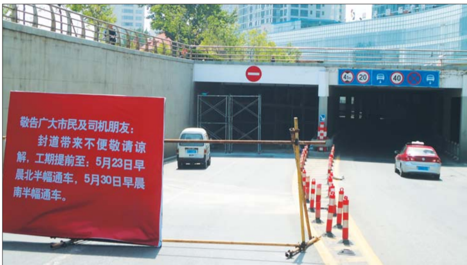
大马路下沉通道施工现场。记者 于飞 摄
