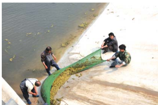
泵站试通水前,清理水中杂草。
